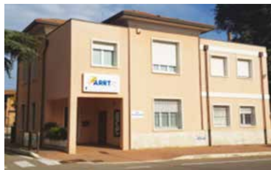
Sede attuale ARRT Via Cavalcavia
